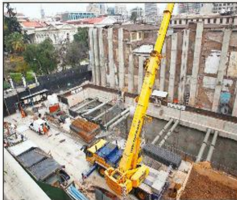
Un 52% alcanzan las obras de extensión del tren subterráneo. La línea 6, que usará Contiflex con Providencia, se entregará en 2017, y la 3, que correrá entre Hundurubal y La Reina, en 2018. En la foto, los trabajos en la estación Plaza de Armas, en la esquina de Guadalupe con Cathedral, que continuará con la línea 5.
